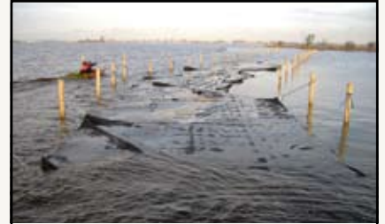
Sistemas de Geotube® preparados para serem enchidos com areia:
