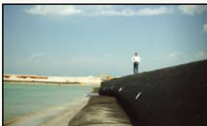
Sistemas de Geotube® são empilhados para produzir este género de estruturas de protecção.
