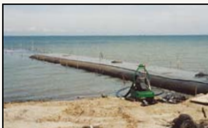
Posicionamento de sistemas Geotube® para criar esporões como enseada para criação de camarões.
